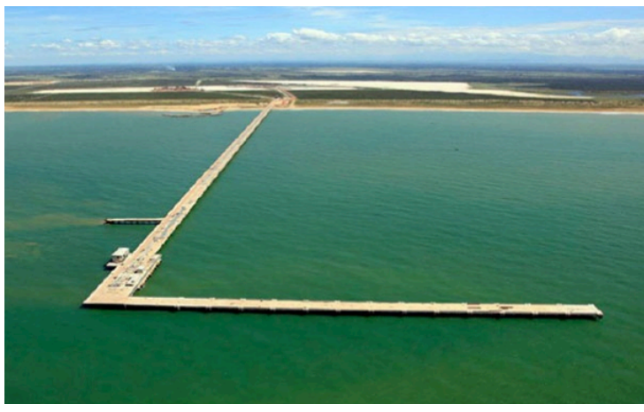
FOTO 2 – PÍER DO PORTO DO AÇO – SÃO JOÃO DA BARRA-RJ
