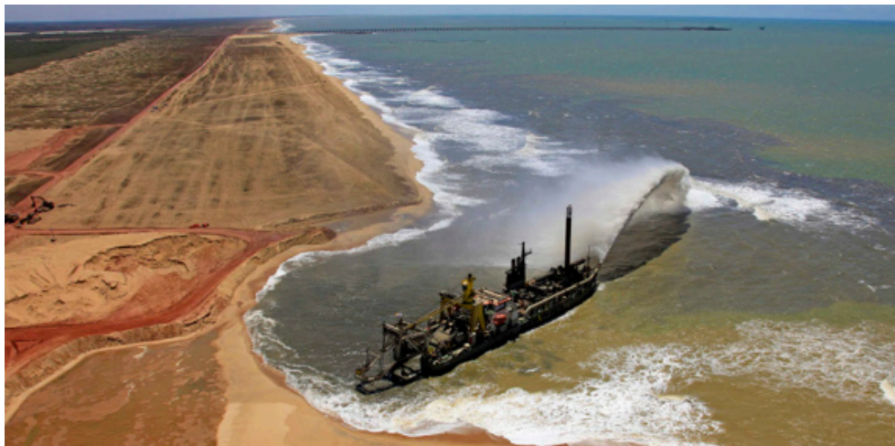
FOTO 26 – DRAGAGEM PARA ABERTURA DO CANAL DE ACESSO AO ESTALEIRO OSX
